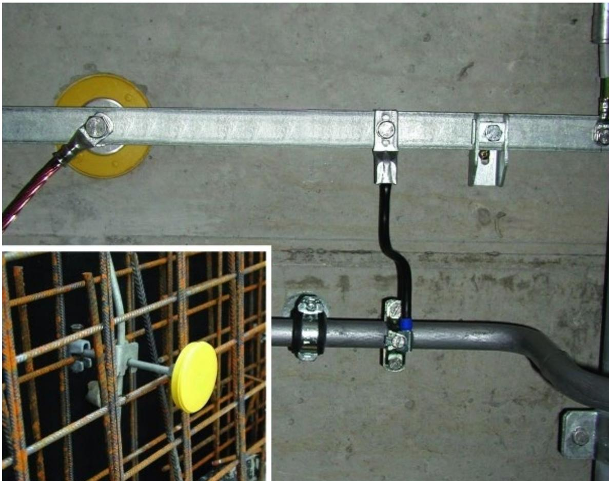
Abbildung 4.36: Erdungsfestpunkte [DEH2016]
